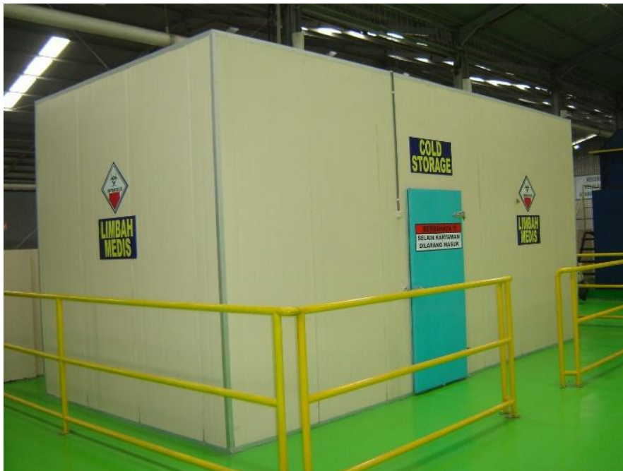
Gambar 2. Contoh ruang pendingin untuk penyimpanan Limbah B3 berupa Limbah infeksius, benda tajam, dan/atau patologis
